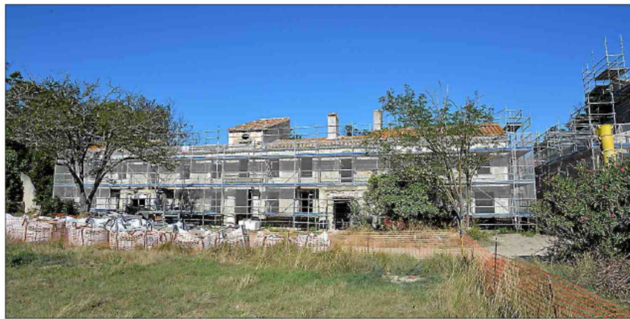
► La maison de maître est la bâtisse principale du domaine qui va être mise à l'abri des intempéries.
